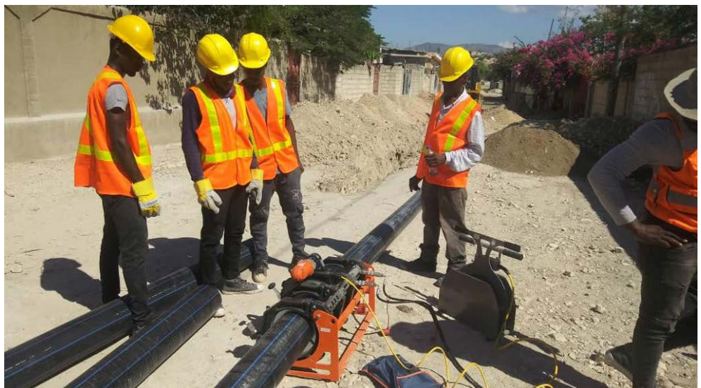
Crédit photo: DINEPA / Travaux de construction de réseau d'eau potable par les techniciens de la DINEPA
