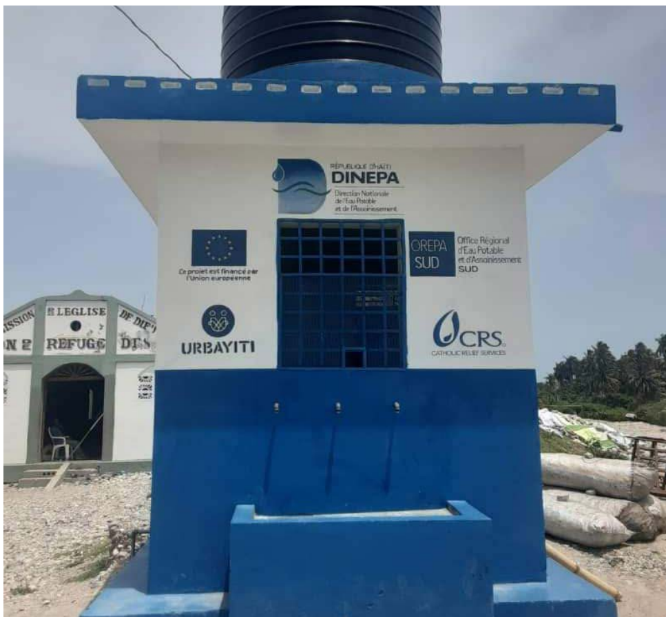
Construction de kiosques à eaux par Catholic Relief Services Haïti, projet Leve Okay - Octobre 2022
