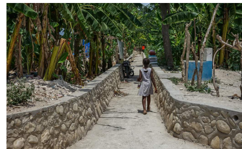
Construction d'infrastructures de drainage à Jérémie, crédit photo : CARE Haiti
