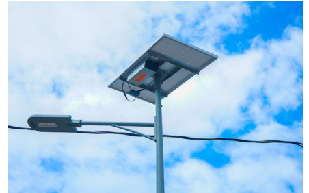
Installation de Lampadaire solaire à Jérémie; Projet Vil nou pi bèl CARE Haiti
