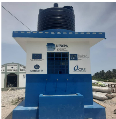
Kiosque d'eau public construit par CRS aux Cayes
